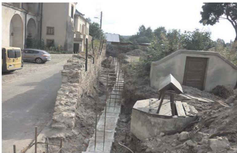
Stary mur w trakcie rozbiórki i fundamenty nowego Na zdjęciu widoczna jest stara piwnica i studnia apteczna
