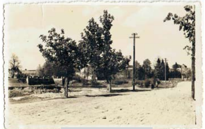
Ul. Kolejowa – widok na upust
