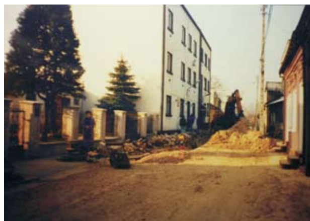
Budowa kanalizacji na ul. Wielkowiejskiej – marzec 1998 r.
