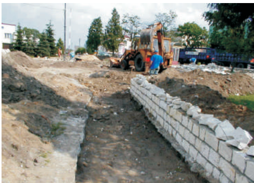
Przebudowa Placu Ponurego – 2004 r.
