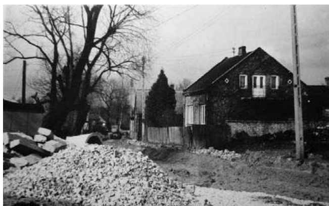
Przebudowa ul. Kolejowej 1978 r.
